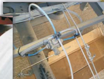
Conductos de aire
